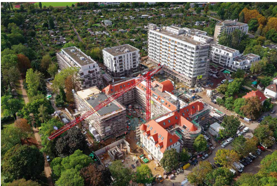
Bild 1. Baustelle Hildegardis – Die Stadt-oase in Mainz. Die Großbaustelle, auf der ca. 445 Wohnungen entstehen, ist Experimentierfeld für die KI.
